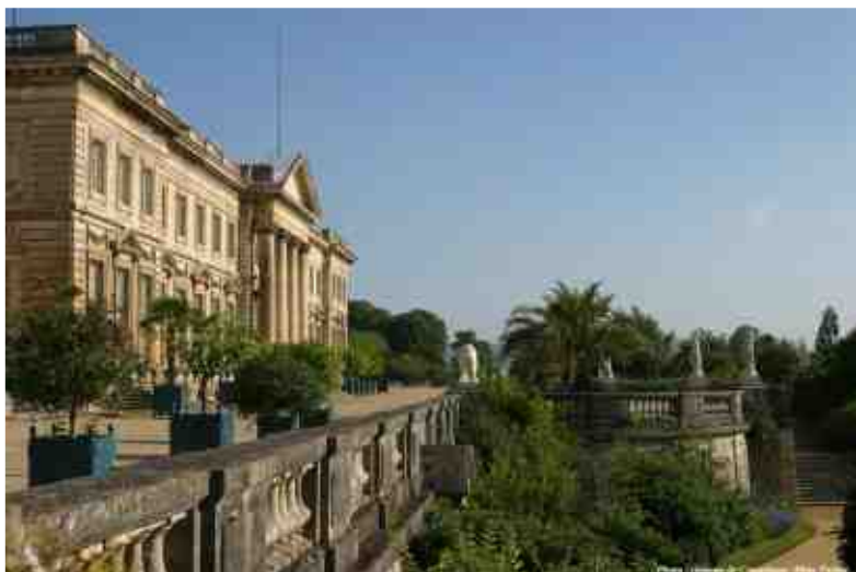
Façade du palais vue du parc (c) Palais de Compiègne/Marc Poirier
